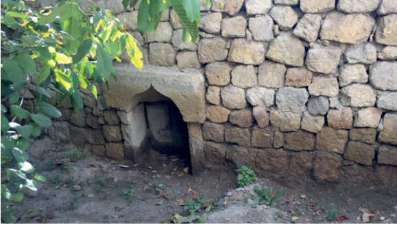
Fotoğraf 2: 2021 yılında İbnidai Mescidi mihrap nişi ve güney duvarlarının görünüşü.
